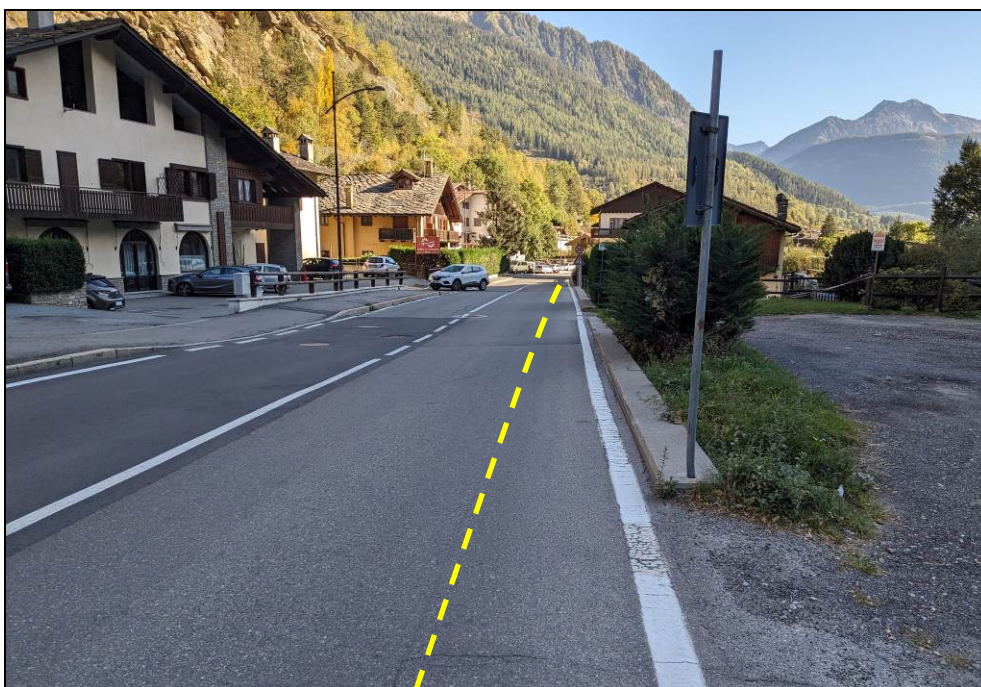
Figura 7 – Strada comunale sotto cui è prevista la posa della condotta forzata
