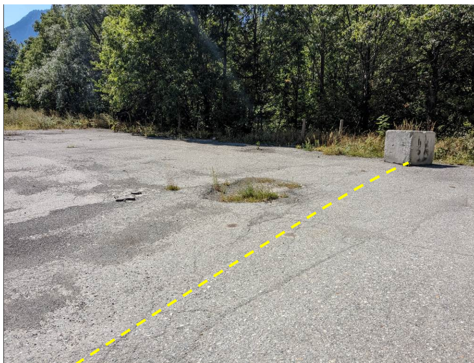
Figura 10 – Area parcheggio, posa del tratto finale della condotta forzata
