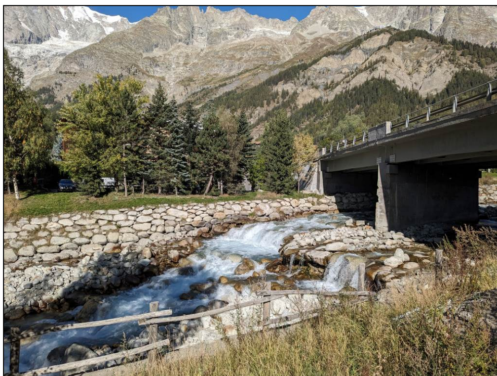
Figura 1 – Soglia esistente, dove è prevista l'installazione dell'opera di presa a trappola
