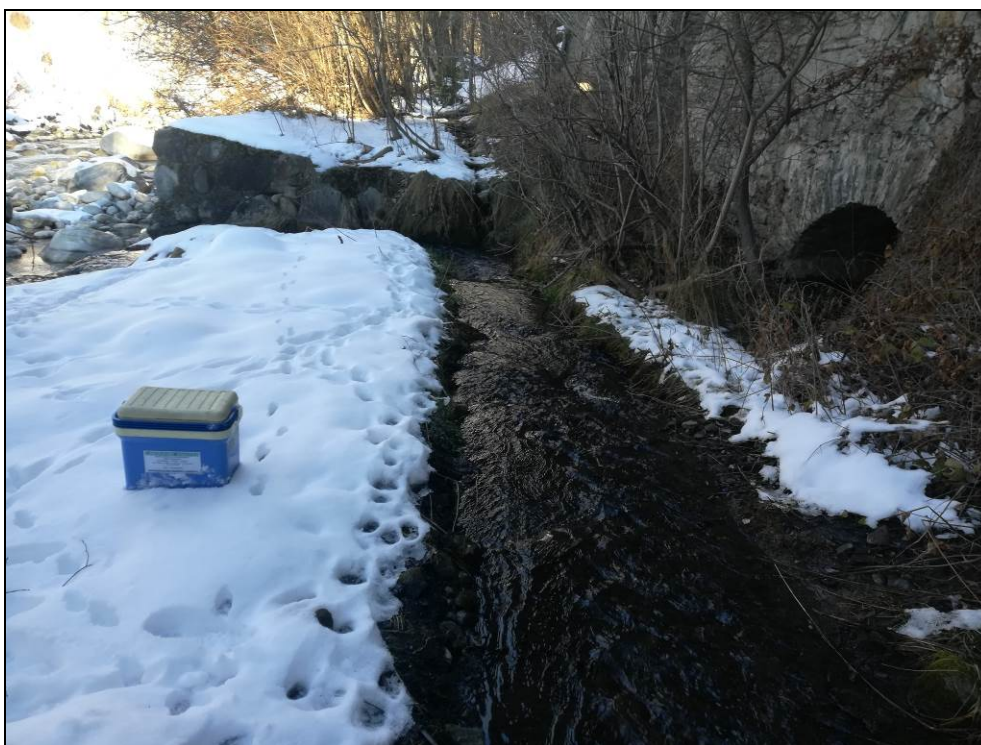
Figura 12 – Canale di scarico esistente, utilizzato per la restituzione delle acque turbinate
